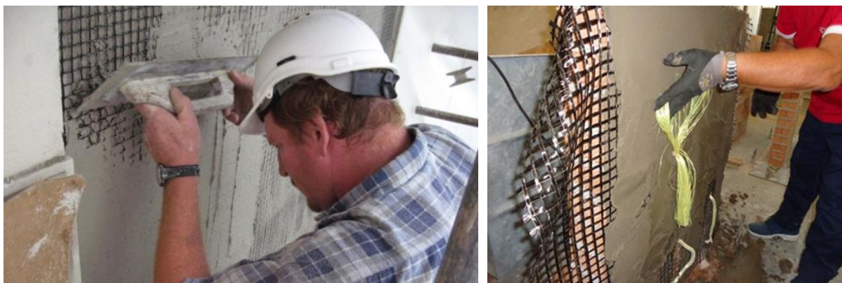
Figura 8: Esempi di rinforzo murario con tecnologia FRCM System.
