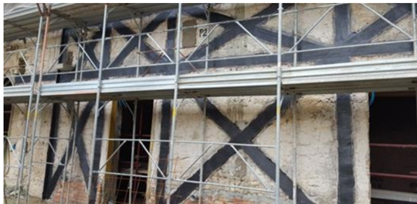
Figura 4: Esempi di rinforzo di rinforzo a taglio e a flessione di murature con tecnologia FRPsystem.
