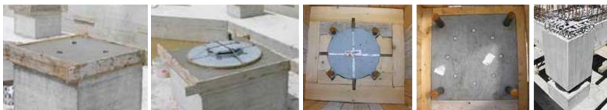
Figura 13: Procedura d'installazione di isolatore friction pendulum su una nuova costruzione.
