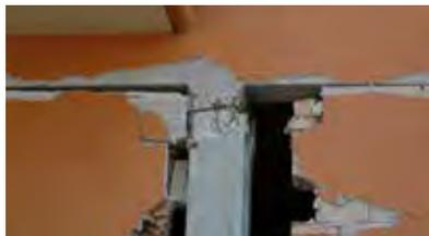
Rottura a taglio di pilastro
