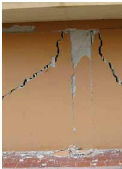
Rottura a taglio di tamponatura
