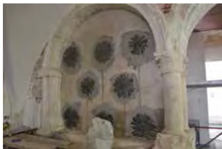
Connessione meccanica aggiuntiva con fiocchi in fibra di carbonio
