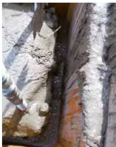
Rinforzo di pilastri con incamiciatura in basso spessore
