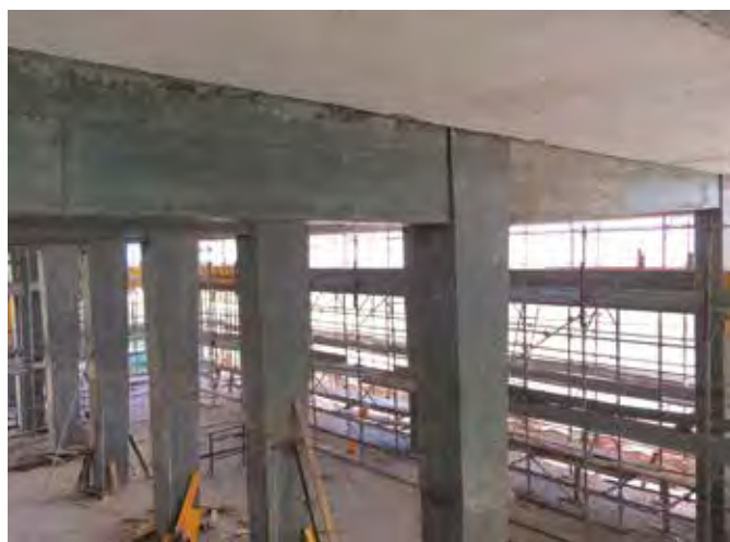
Rinforzo di travi e pilastri con incamiciatura in basso spessore
