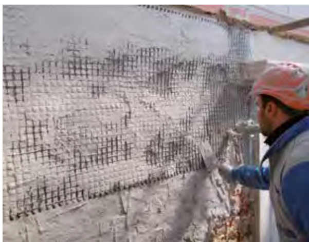
Applicazione del rinforzo in basso spessore per incrementare la resistenza a taglio-trazione di maschi murari
