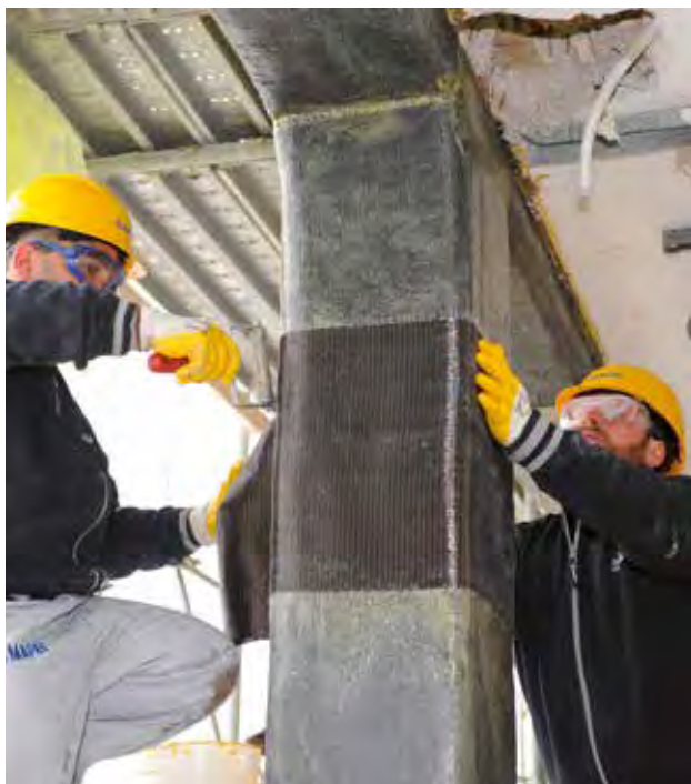
Rinforzo di un nodo trave-pilastro con MAPEWRAP C SYSTEM
