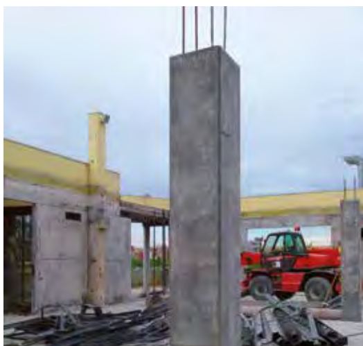
Rinforzo di pilastri con incamiciatura in basso spessore
