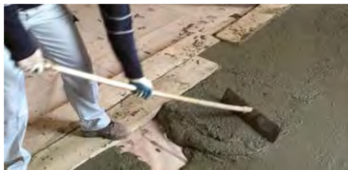
Rinforzo estradosale di solaio in legno
