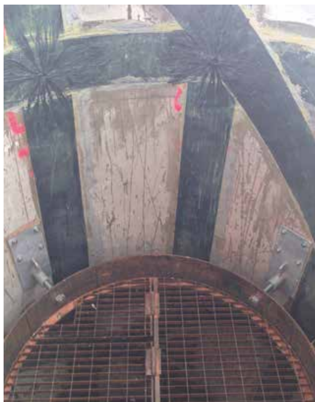
Rinforzo di ciminiera in mattoni con MAPEWRAP C SYSTEM
