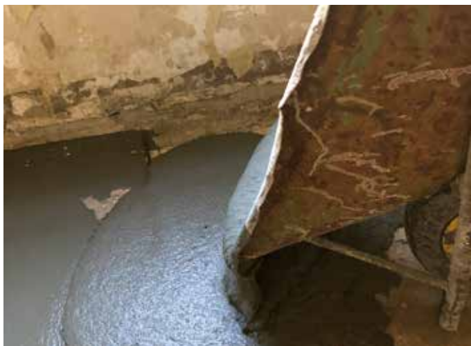
Rinforzo estradosale di solaio in latero-cemento
