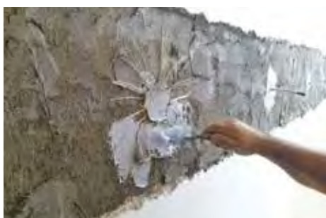
Applicazione di sistema FRCM come antiribaltamento di tramezze e tamponamenti
