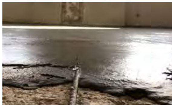
Rinforzo estradosale di solaio in latero-cemento
