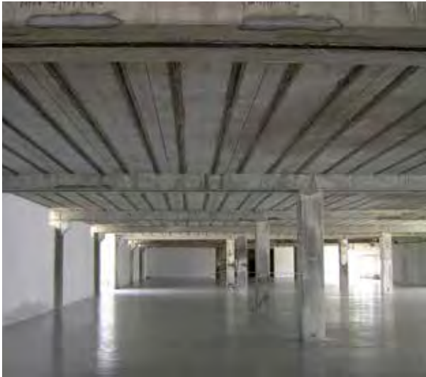
Rinforzo a flessione di travi e solai con CARBOPLATE SYSTEM
