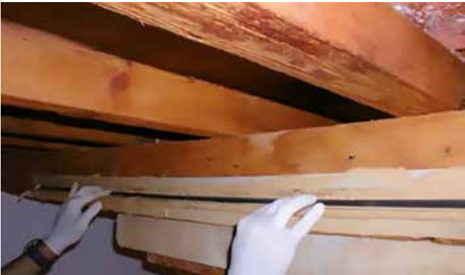
Rinforzo di trave in legno con MAPEROD SYSTEM
