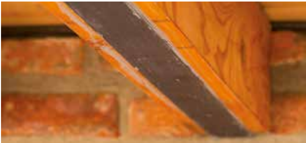
Rinforzo a flessione di trave in legno mediante placcaggio con CARBOPLATE SYSTEM
