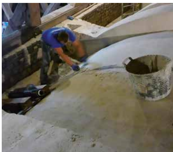
Rinforzo estradossale di volte in muratura
