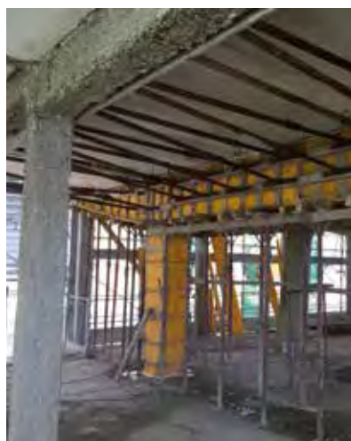
Rinforzo di travi e pilastri con incamiciatura in basso spessore
