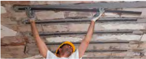
Applicazione di CARBOPLATE SYSTEM su travetti di solaio latero-cemento
