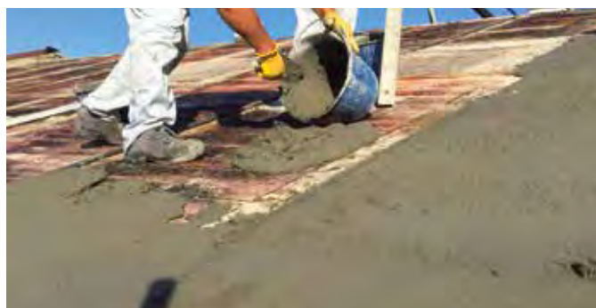
Rinforzo di solai di copertura in falda
