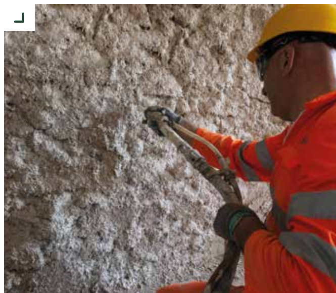
Applicazione a spruzzo di PLANITOP INTONACO ARMATO
