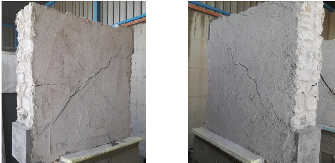
Figura 8. Quadro fessurativo dei pannelli rinforzati su due lati
