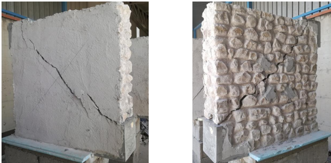
Figura 7. Quadro fessurativo dei pannelli rinforzati su un solo lato
